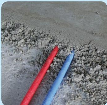
**1** Une chape d'égalisation (thermique\*) permet de couvrir les gaines et tuyaux.
