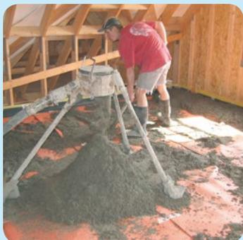
**5** Ne pas oublier de protéger la membrane contre le poinçonnement du trépier de la pompe à chape.
