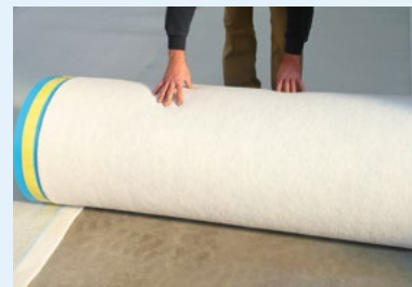
Respecter un recouvrement sur le rouleau adjacent
