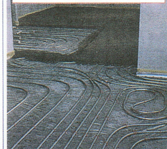
Installation de chauffage au sol
